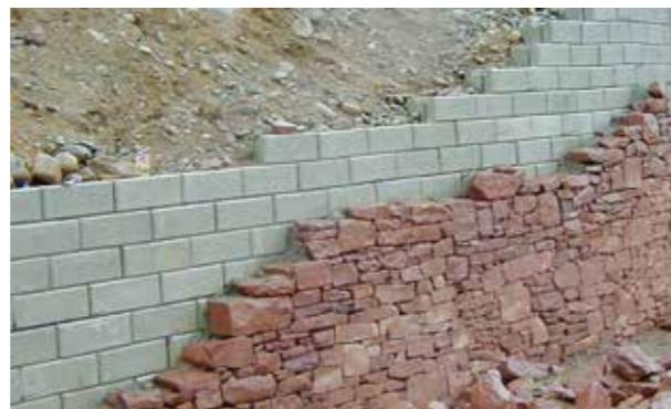
通过坦萨TW挡墙系统结合不锈钢连接构件，可以轻易实现类似图示砂岩饰面的附加面板效果
