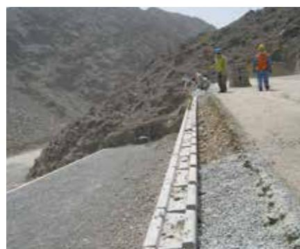
采用坦萨独特的模块挡墙系统，施工简单，无需吊机或支撑，可以将费用减至最少。
