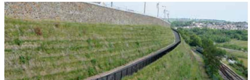
通过挑选适合当地气候条件的植物，TensarTech™ 生态陡边坡可以很快形成绿化坡面。
