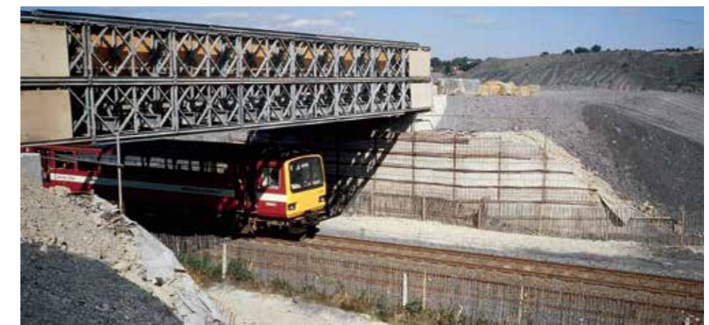
TensarTech™ 系统通常用于修建造价较低的临时桥台结构。
