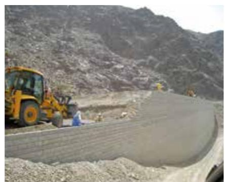
模块与格栅很容易连接，所有TensarTech™挡墙系统面板连接很简单，而且安全性好。
